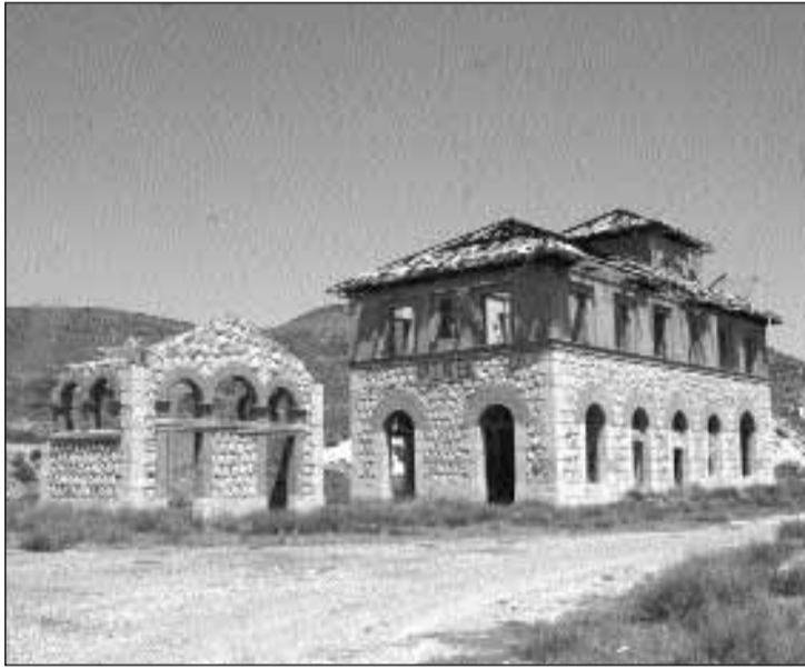
Restos de la estación de Villalba Baja, en la línea Teruel-Alcañiz
