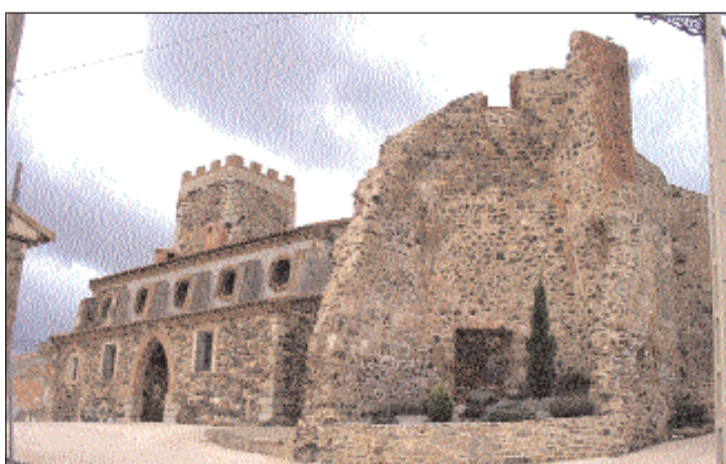
Unas ruinas asentadas y bien conservadas, aliciente para los visitantes
